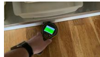
Ved bruk av fuktindikator registrerte jeg ingen forhøyede verdier.
