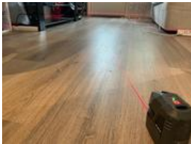
Nivellering stue/kjøkken i kjeller, ingen store avvik registrert. Betongdekke.
