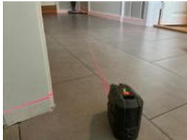
Nivellering entré, avvik ca. 10-20 mm
