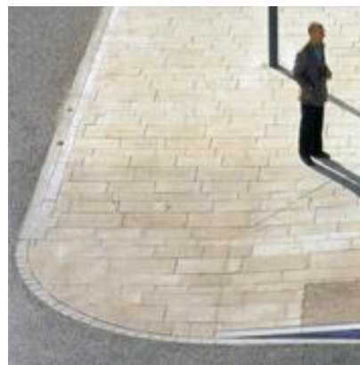
Universell utforming, her eksemplifisert ved en myk overgang mellom gate og fortau.
