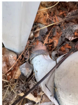
Takvann er ført vekk fra grunnmur via rør i grunn.
