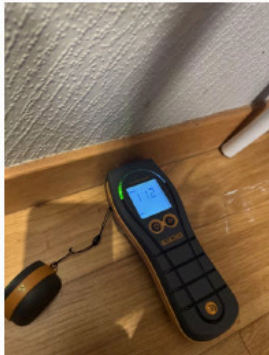
Måling av fukt i bod mot sør vest side ga ingen utslag.
