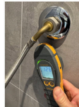
Ingen utslag på fukt ved måling på erfaringsmessig utsatte områder.
