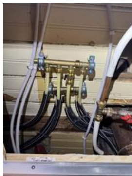
Åpen rørfordeling over himling på bad.
