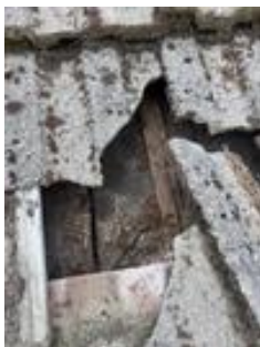
Knuste stein og manglende undertak.
