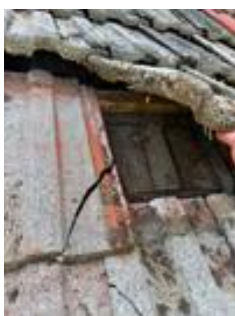
Knuste stein og manglende undertak.
