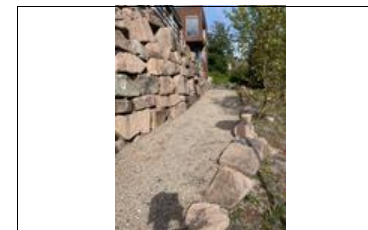
Gruset adkomst opp til huset og gårdsplass.
