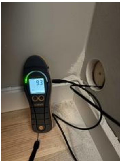
Hulltakking med fuktmåling fra tiliggende soverom ved dusjsonen viser normale fuktverdier.
