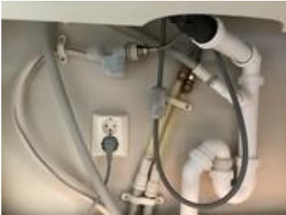
Avløpsrør i underskap vask på kjøkkenet.
