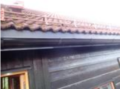
Yttertak mot gaten
