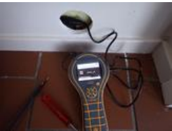
Hulltagning i vindfang bak badekar, 22.08.2025
