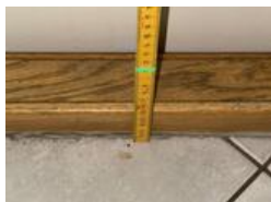
Fallforhold ca. 110 mm overkant gulv ved terskel
