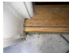
Membran oppbrett ved terskel
