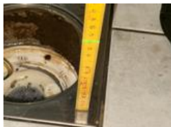
Fallforhold ca. 130 mm topp slukrist i dusjsone
