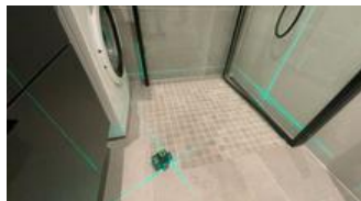
Fall til sluk målt med laser.
