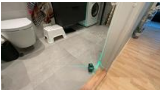
Fall til sluk målt med laser.
