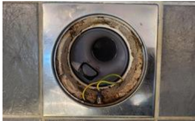
Membran, tettesjikt og overgang til sluk. - [Sluk bad]
