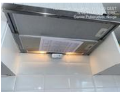
Test av avtrekk
