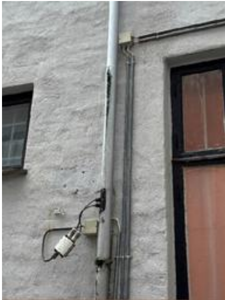
Frostsprengt nedløpsrør
