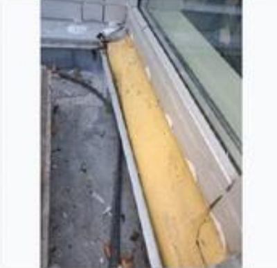
Foto 27 Opprinnelig vindusbeslag ble fjernet for kontroll av membran mm.
