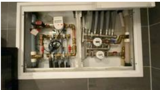
Besiktigelse av røropplegg.
