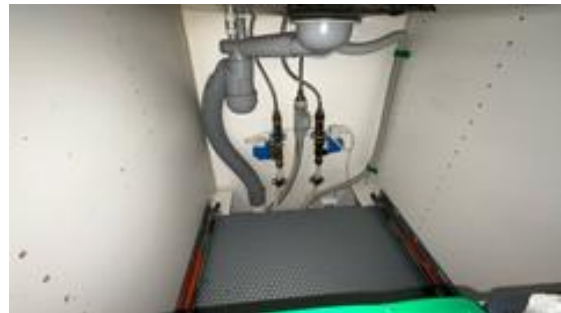
Besiktigelse av røropplegg.
