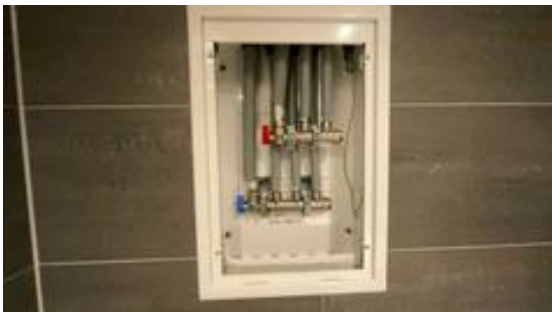
Besiktigelse av røropplegg.
