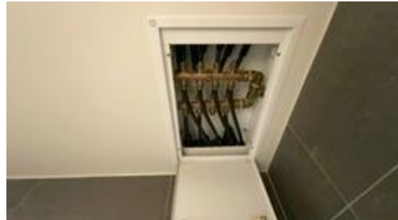
Besiktigelse av røropplegg.
