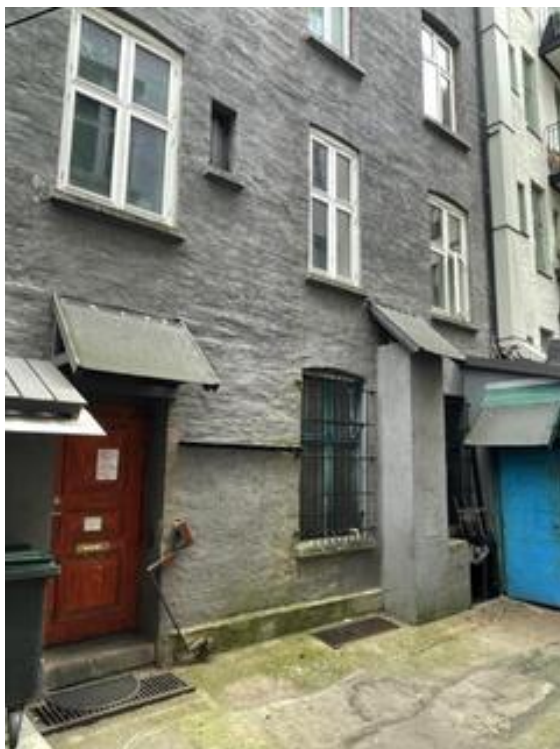
Fasade mot bakgård
