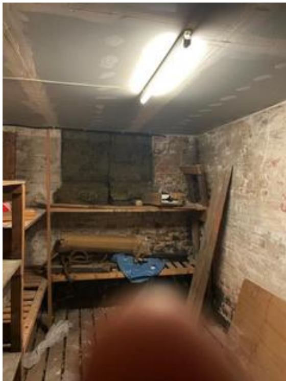
Arbeider utført i 2021-kjeller. Brannskille etablert i himling
