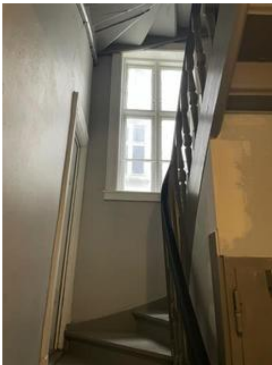
Baktrapp i 1. etasje
