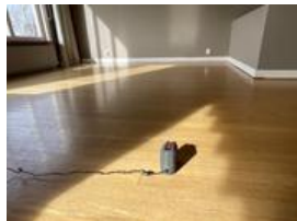
Nivellering stue/trapperom, ingen registrerte avvik
