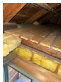
Etterisolert på loft. Senket himling i 2. etasje
