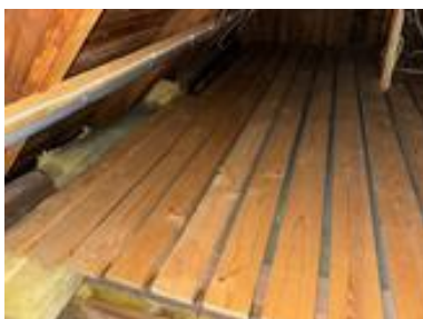
Etterisolering med plastfolie mot kald side
