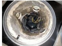
Hovedsluk omtrent midt på gulvet.
