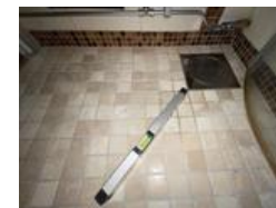
Fallforhold målt i retning sluk.
