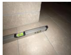
Svakt motfall i retning sluk.
