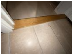
Overgang ved dørterskel.
