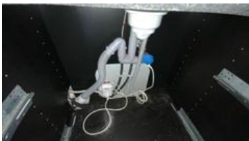
Besiktigelse av røropplegg.
