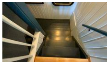
Besiktigelse av trapp.
