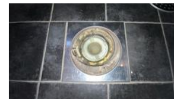
Kontroll av sluk.
