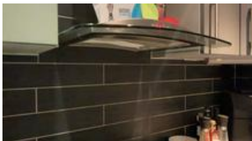
kullfilteravtrekk fra kjøkken
