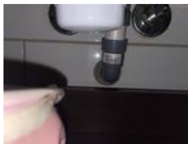
Membran blir registrert smurt rundt gjennomføring under servant.
