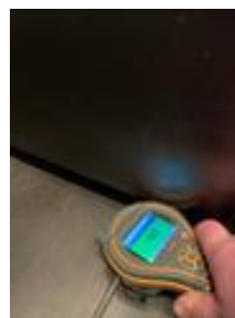
Fuktsøk på gulv foran installasjoner med vann.
