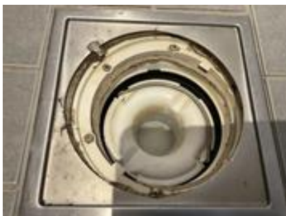
Sluk i dusjsonen.
