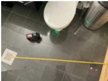
5 mm hellning fra gulv ved dørterskel til sluk.
