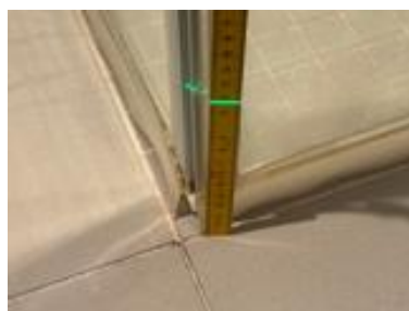
Fallforhold ca. 117 mm overkant gulv ved dusjsone
