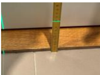
Fallforhold ca. 108 mm overkant gulv ved terskel
