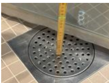
Fallforhold ca. 140 mm topp slukrist i dusjsone
