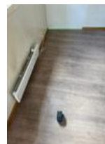
Foto viser nivellering med krysslaser i alkove
