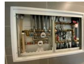
Besiktigelse av røropplegg.
