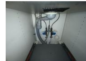
Besiktigelse av røropplegg.
