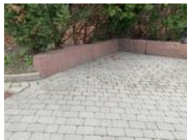
Løs fug, løse skifer, ujevnheter, skjevheter mm.
