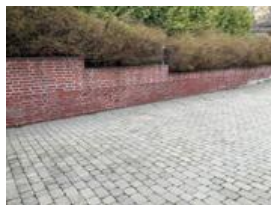
Løs fug, løse skifer, ujevnheter, skjevheter mm.
