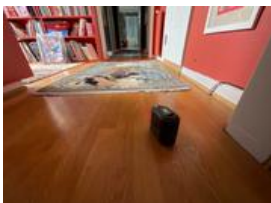
Nivellering gang + soverom 2 etasje, ingen avvik registrert
