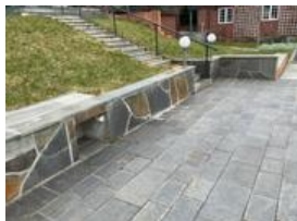
Betongmur belagt med skifer
