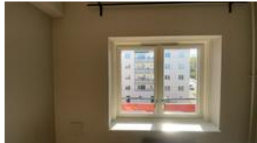
Lufteluke og luftespalte.
