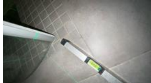
Fallforhold målt i retning sluk.
