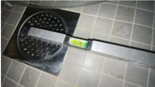
Fallforhold målt i retning sluk.
