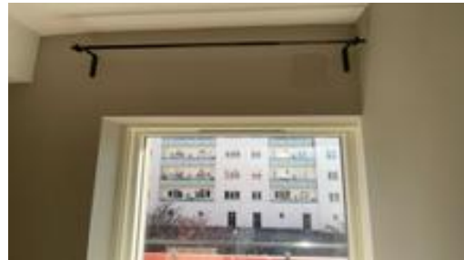
Lufteluke og luftespalte.
