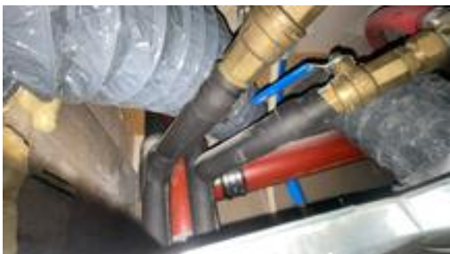
Avløpsrør i rød farge.
