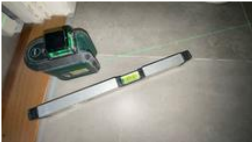
Fallforhold målt i retning sluk.
