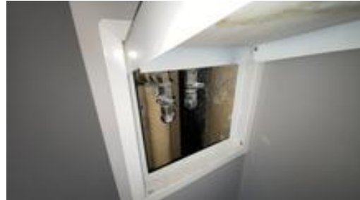
Blendet rør på ett soverom (tidligere kjøkken).
