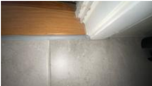
Overgang ved dørterskel.
