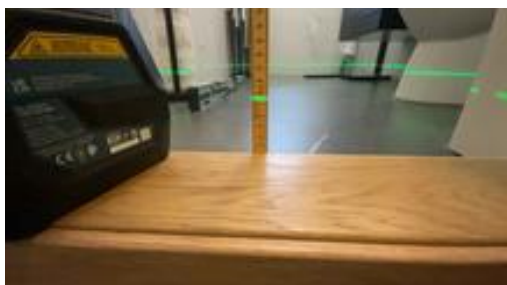
Høydeforskjell (flis ved terskel)
