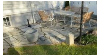
Helleplattning på grunnen utenfor stue.
