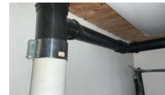
Nyere avløpsrør av plast koblet inn på hovedstamme av støpejernsrør.
