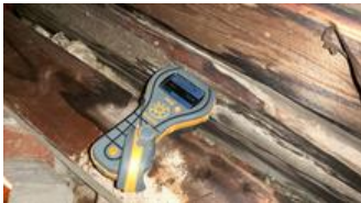
Ved fuktmåling registrerte jeg ikke unormale verdier.
