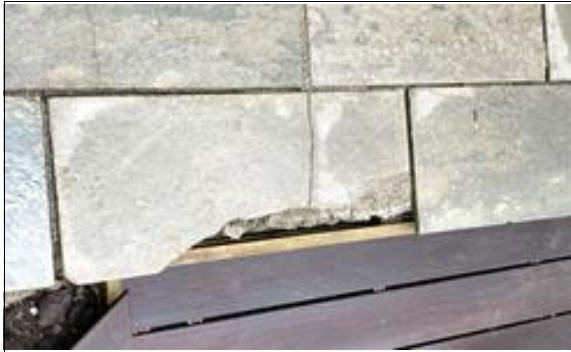
Knust skiferflis ved inngangsparti
