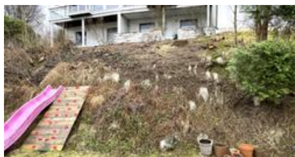
Skrånende terreng i øvre del av eiendommen.
