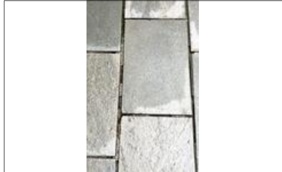
Slitte fuger med skiferheller ved inngangsparti
