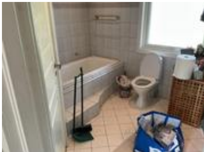
Baderom av eldre oppbygging
