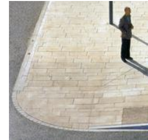
Universell utforming, her eksemplifisert ved en myk overgang mellom gate og fortau.
